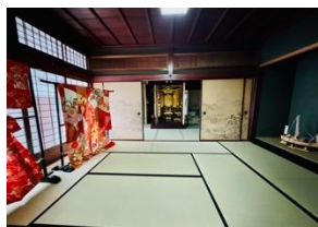
ナカノマ（1階） 右側の床框は黒漆溜塗り
