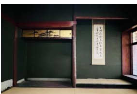
茶室（1階） 床柱は皮付きの赤松。 床框は黒檀、書院板はケヤキ、違い棚・床板は松の1枚板。
