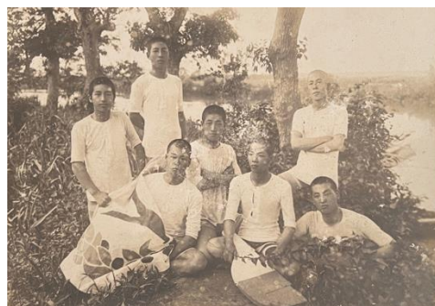
5代目平安（1895-1973）は石川県立小松中学校時代（現・小松高等学校）、短艇（カッターボート）の選手だった。軸手は12代目西出孫左衛門（西出悌二）が務めるなど、橋立の北前船主関係者の子弟のチームだった。大正2年撮影。
