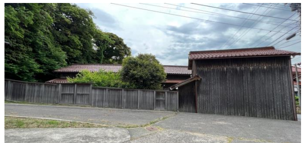
雖然從一開始就採用了瓦頂，但外部斜頂的結構保留了茅草時期的技術。展示了橋立北前船主宅邸的發展歷程。
