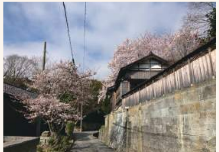
旧増田又右衛門邸の石垣と塀。 石垣の表面は笏谷石、内部は深田石。
