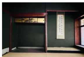
茶室（1階） 床柱は皮付きの赤松。 床框は黒檀、書院板はケヤキ、違い棚・床板は松の1枚板。
